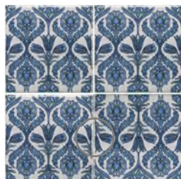
Dit is onjuist, want de patronen aan de zijkan- ten sluiten niet op elkaar aan, aangezien de tegel rechtsonder ondersteboven is aangebracht
